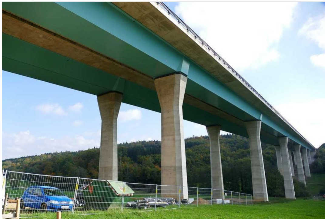
Die Dultenaugrabenbrücke zwischen Lörrach und Rheinfelden Foto: Peter Gerigk
